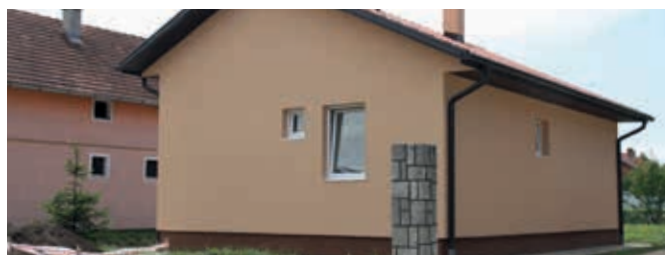
Izgradnja preko 300 montažnih kuća širom Srbije
