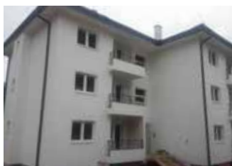
Izgradnja 512 stanova u višestambenim zgradama, Bosna i Hercegovina
