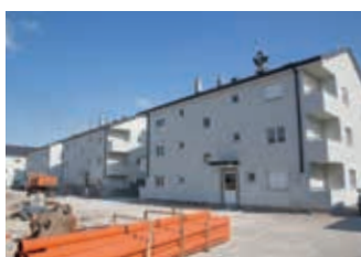
Izgradnja 120 stanova Konik, Crna Gora
