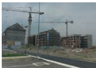
Izgradnja 235 stanova, Ovča, Beograd, Srbija
