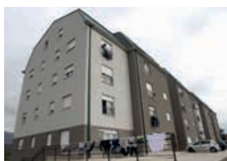
Izgradnja 62 stana Nikšić, Crna Gora
